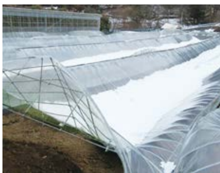
降雪で倒壊したハウス
